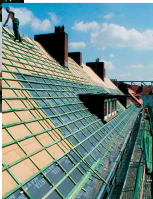
Arbeiten in Bremen Findorff
