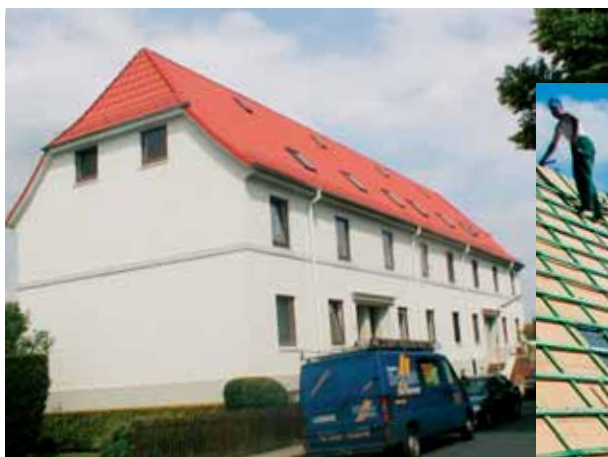
Sanierte Dachfläche in Bremen-Sebaldsbrück
