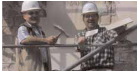
Die Maurerabteilung mit Detlef Folkers (l.) und Wolfgang Schaar im Einsatz: In der Thielenstraße werden momentan die Balkone ausgebessert.
