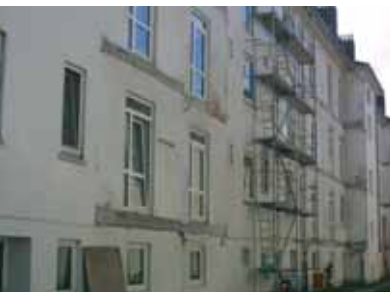
So sieht es im Innenhof der Eickedorfer Straße 31 bis 36 aus: Die alten Betonbalkone werden abgerissen und durch neue Alu-Vorstellbalkone ersetzt.
