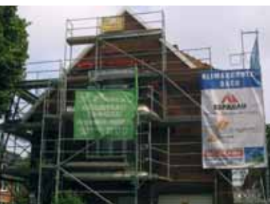
Meraner Straße 9 bis 11: Im Objekt in der Nachbarschaft der Geschäftsstelle wird mit einem neuen ClimaLife-Dach die Wohnqualität verbessert.
