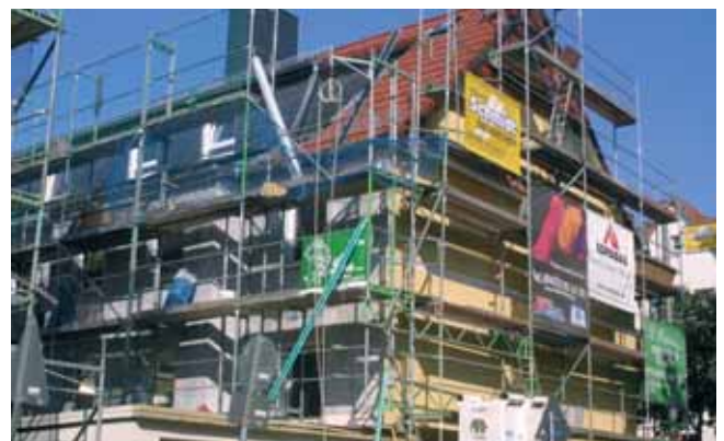
Hinter diesem Gerüst steht das Wohnhaus Borgfelder Straße 17/Herbststraße 117 und 119: Hier wurde die Außenfassade mit wärmedämmenden Platten ausgestattet, das Dach erneuert.
