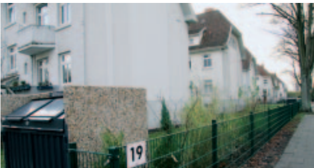
Neugestaltung der Brebacher Straße in Sebaldsbrück: Neue Hauszuwegungen zieren die Außenanlage.
