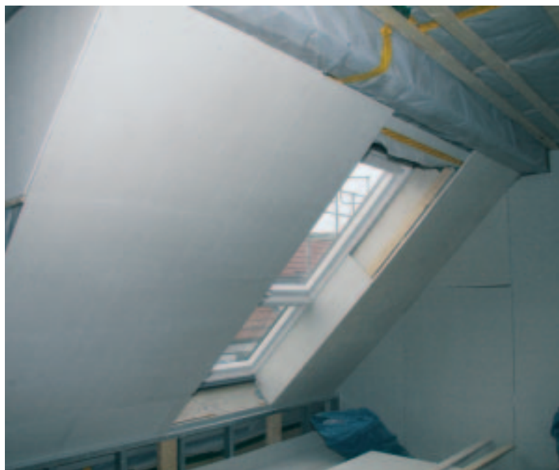
Borgfelder Straße 4: In dieser Dachgeschosswohnung sind die Schrägen bereits mit Platten verschalt.
