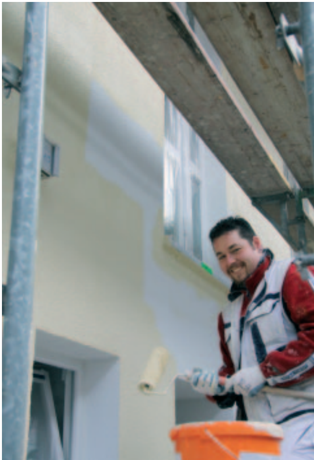
Gute Stimmung unter den Handwerkern wie hier bei den Malern: Der trockene Herbst verkürzte einige Sanierungsarbeiten.
