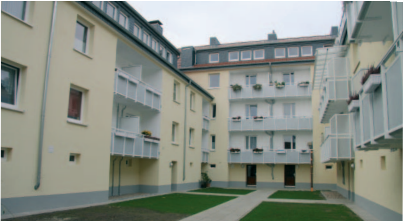
Die monatelange Sanierung ist abgeschlossen und trägt zur Lebensqualität bei.
