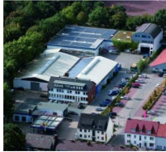
Das Firmengelände der Friedrich Schmidt GmbH von oben: Seit nunmehr 105 Jahren bestehen die Dachdecker-Spezialisten, mit der ESPABAU gibt es seit Jahren ein vertrauensvolles Verhältnis.
