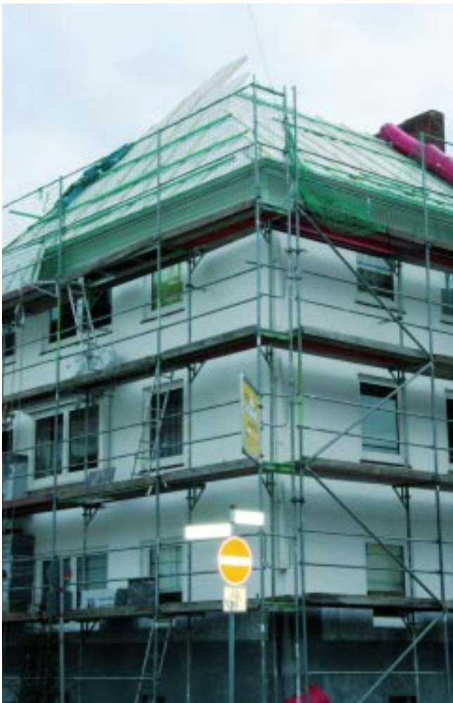
Baustelle Herbststraße 111 und 111a.
