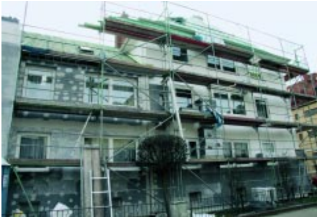
Baustelle Katrepeler Straße.
