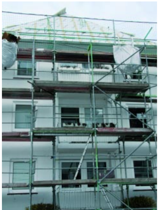
Baustelle Timmersloher Straße/Ecke Herbststraße.
