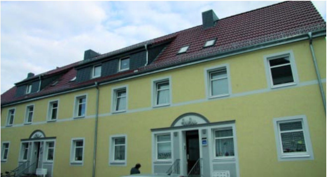
Das Dach, die Außenfassade, der Eingangsbereich, die Haustüren – alles ist saniert in der Herbststraße 113-115.
