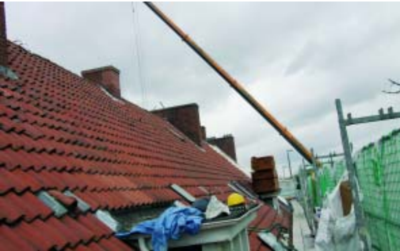
Die Baustelle in 20 Meter Höhe: Hier sind noch die alten Dachpfannen zu sehen.
