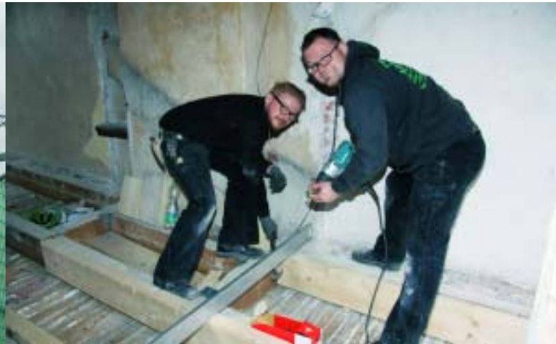
Ein Blick in eine Dachgeschoßwohnung: Der Fußboden wird mit neuen Balken ausgelegt, später mit hochwertigem PVC in Holzoptik versehen.
