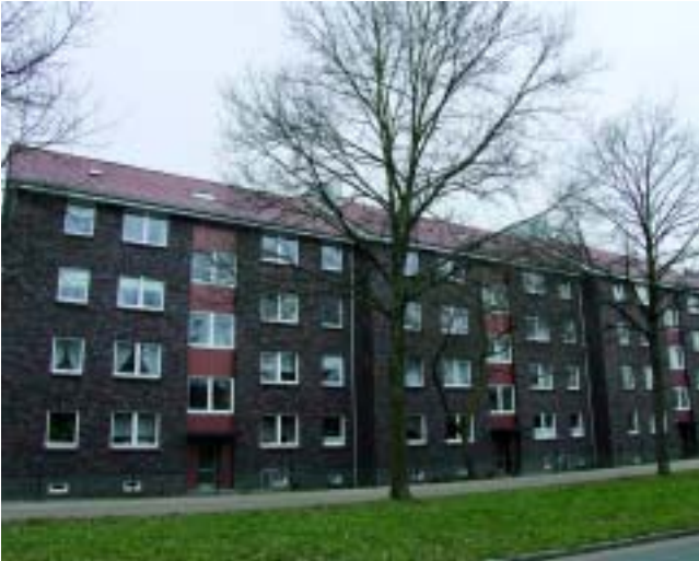
Ein schöner Anblick: In der Kasseler Straße 62 – 72 sind die Sanierungsarbeiten samt Außenanlage abgeschlossen.
