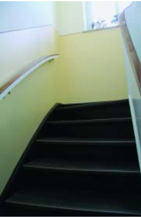
Modern und gut anzuschauen: Alle Treppenhäuser im 1. und 2. Bauabschnitt wurden komplett saniert.
