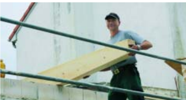
Tom Grunert von der Firma Siems richtet gerade die Balken für den Flachbau mit Vordach aus.
