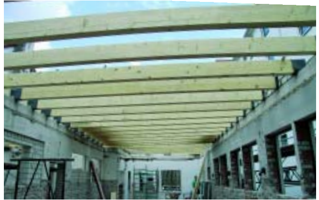
Die neuen Balken für das Flachdach, die Räumlichkeiten bieten Platz für rund 20 Kinder.
