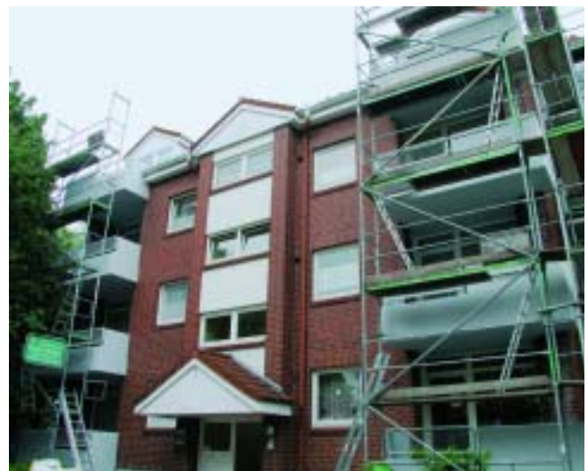
Gustav-Heinemann-Straße 89-99: Neue Balkonanstriche und Beschichtungen sind in Arbeit.
