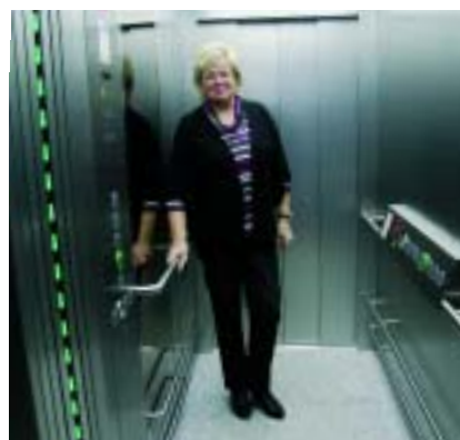
Hausmeisterin Franka Neermann-Azeroth ist glücklich: Im Wohnheim wurde gerade die neue Aufzugsanlage eingebaut.
