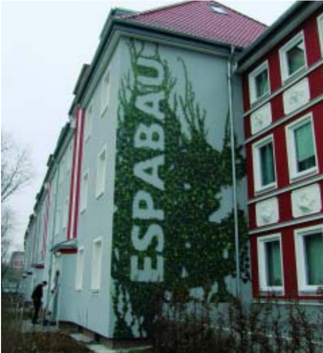
So zeigt sich das Objekt Utbremer Ring/Ecke Hemmstraße: An der Außenfassade rangt sich das Efeu mit den Lettern ESPABAU.
