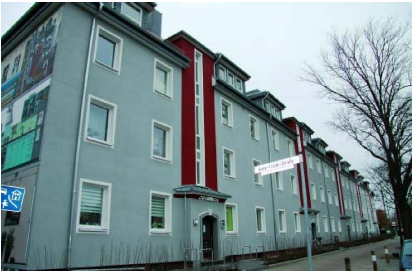
Hemmstraße 260 – 278/Ecke Anne-Frank-Straße: Rechtzeitig zum Winter sind die Arbeiten des 3. und 4. Bauabschnittes so gut wie fertig geworden. Momentan sind letzte Handgriffe für die Außenanlage erforderlich.
