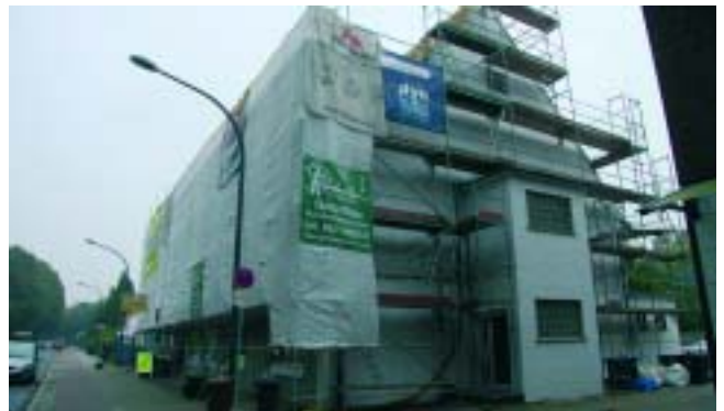
Lesumer Heerstraße 83 – 87 wird jetzt samt Dach, Außenfassade und Balkone saniert.
