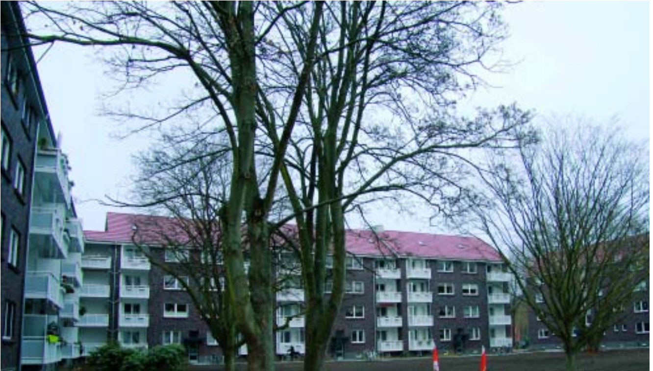
Kasseler Straße 74 – 80: Die Sanierungsarbeiten samt Außenanlage sind nahezu abgeschlossen.
