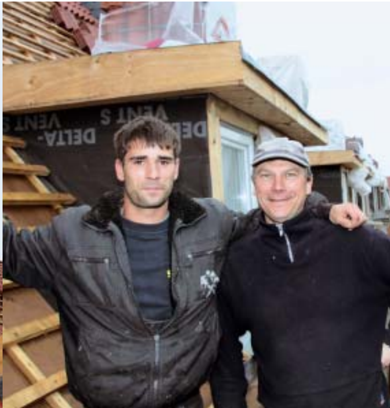
Sie sind vor Ort für den Ausbau der Dachgeschoßwohnungen verantwortlich: Tom Grunert (r.) von der Firma Siems und der Vorarbeiter der Dachdecker, Didi Thurau, von der Firma Friedrich Schmidt.
