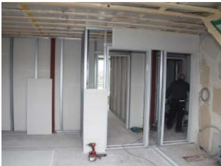
Der Blick in eine Dachgeschoßwohnung: Die Trockenbauer verwenden Metallprofile für die Wände.
