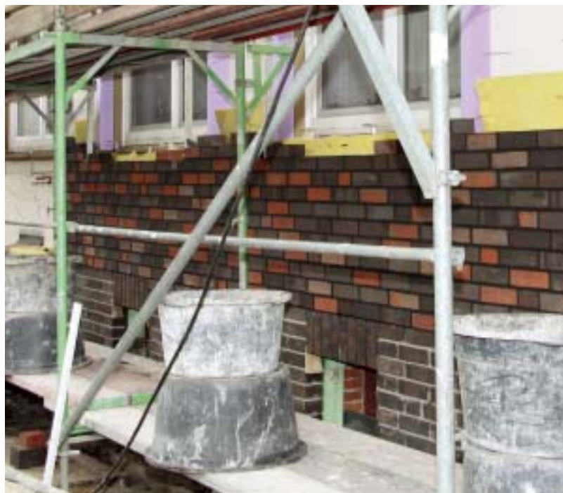
Die Kasseler Straße 62 – 72: Die Gebäude erhalten eine Klinkerfassade.
