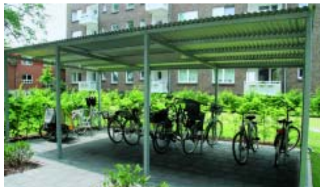
Der Innenhof der Kasseler Straße 39 – 49: Hier wurde bereits ein Musterhäuschen als Fahrrad-Unterstellplatz errichtet.
