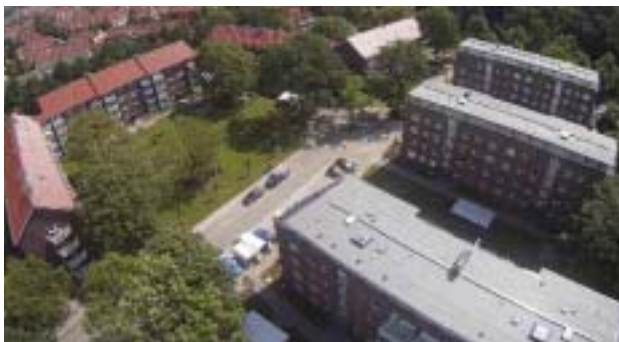
Kasseler Straße nach Modernisierung/Dachgeschöbausbau (Vogelperspektive)
