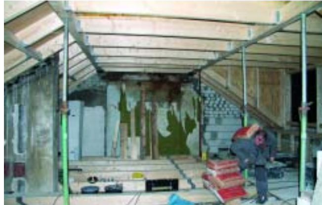
Der Dachstuhl steht, es beginnen die Vorbereitungen für den Innenausbau.
