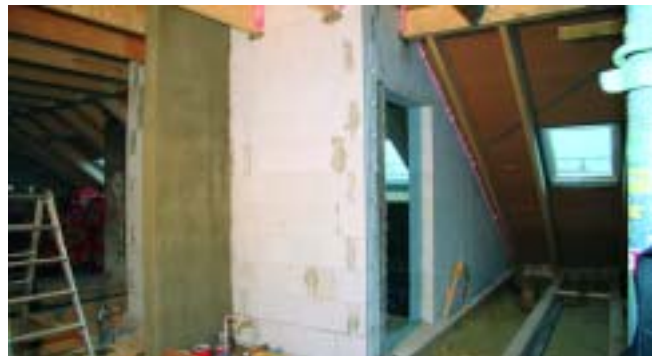
Immer mehr Auflagen bei Sanierungsarbeiten: Die Brandschutzmauer im Dachgeschoss ist gezogen.
