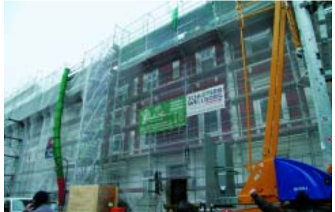
Die Grünbergstraße 3, 5 und 7 im Sanierungszustand: Das ist momentan die größte Baumaßnahme der ESPABAU.
