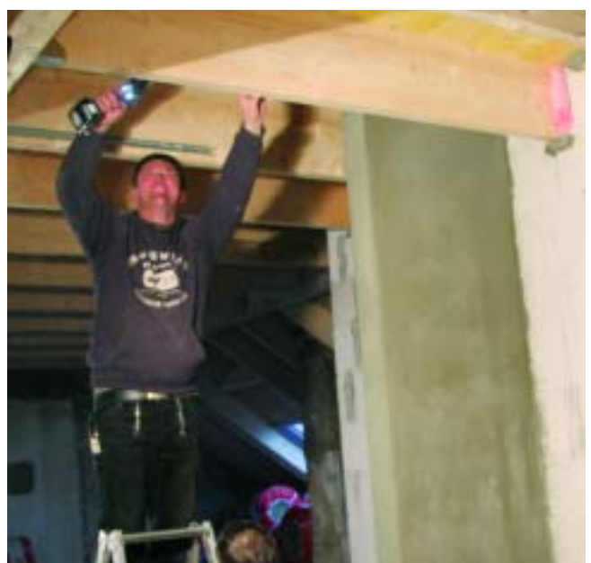
Die Zimmermänner verschrauben die Holzkonstruktion des Dachbodens.
