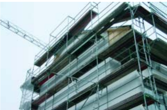
Die Außenfassade ist gedämmt, in 22 Meter Höhe steht der Dachstuhl für die neuen Dachgeschosswohnungen.
