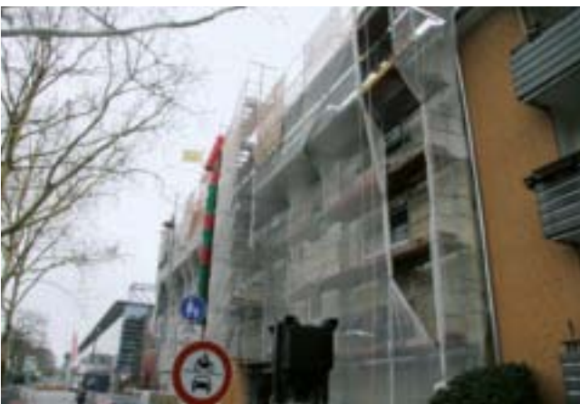
Baustelle Eickedorfer Straße 2/3 und 4/5: Vor kurzem haben die energetischen Arbeiten begonnen.
