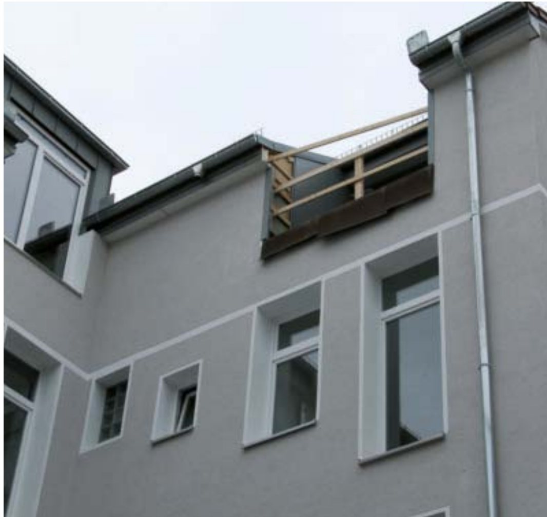
Eine Loggia mit einem vorgelagerten Balkon entsteht in der Wohnung Winterstraße 45.
