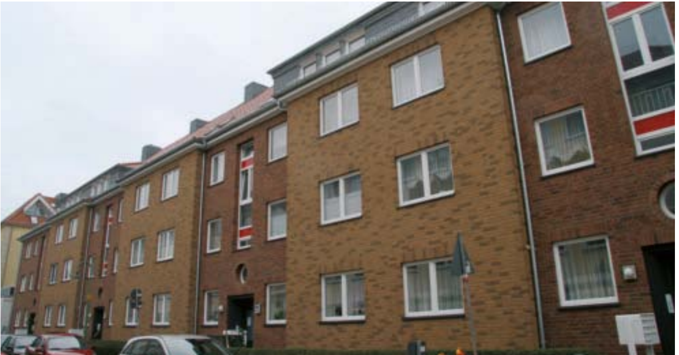
Die Buddestraße ist fertig: Der „Meldorfer Verblender“ ziert den Gebäudekomplex auf.
