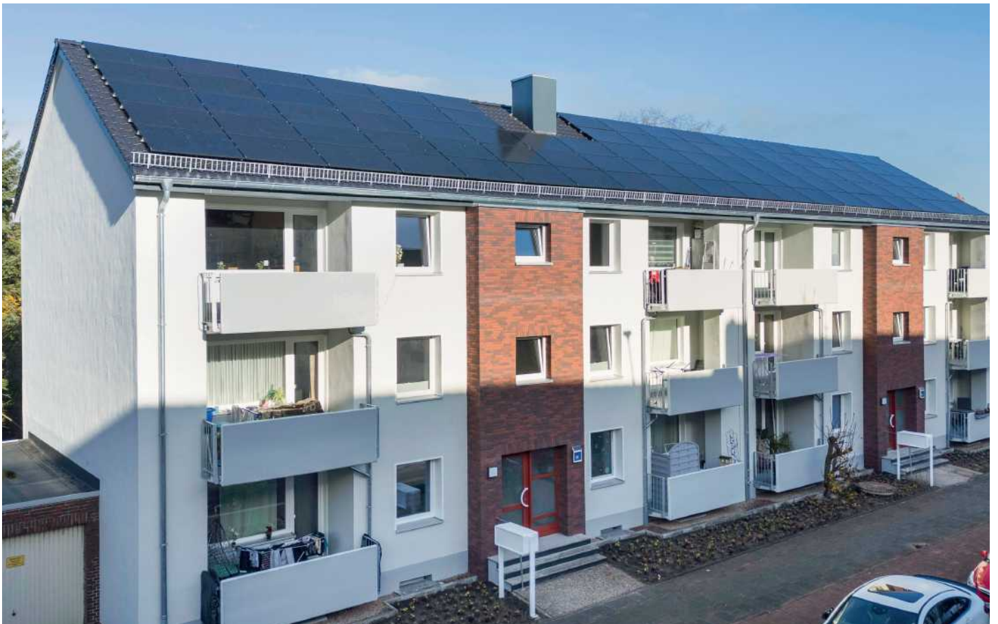
In der Hammersbeckerstraße 49–51 wurden die Fassade, die Fenster, das Dach und die Heizungstechnik umfangreich modernisiert. Das Objekt wird nun mit einer Luftwärmepumpe beheizt. Den Strom für diese Anlage liefert die neu installierte Photovoltaikanlage.
