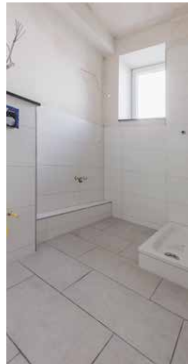
Bild unten rechts: In neuem Glanz erstrahlt das Badezimmer der Wohnung Am Gaswerk 7/9 in Woltmershausen.
