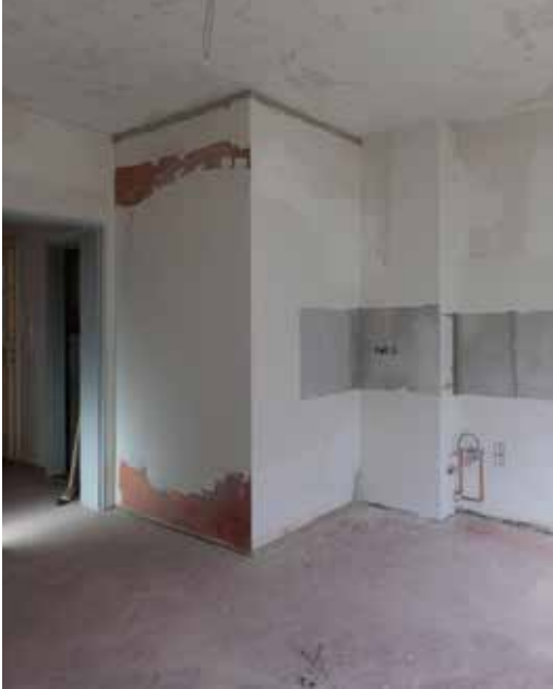
Aus alt mach neu: In der Thielenstraße 5/7 in Findorff sind die Sanierungsarbeiten in vollem Gange.
