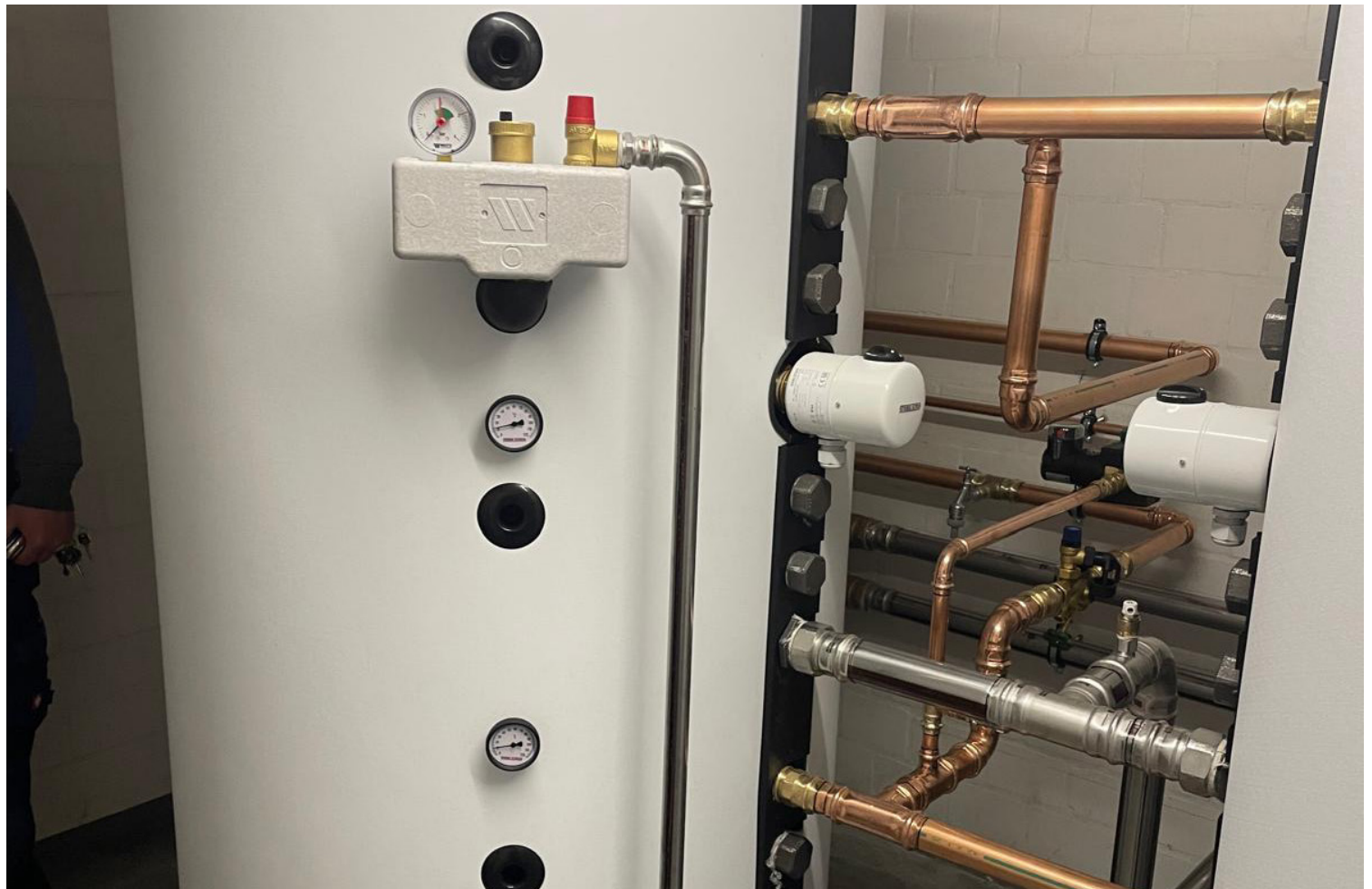
Neue Wärmepumpen mit Pufferspeichern in der Gustav-Heinemann-Straße.
