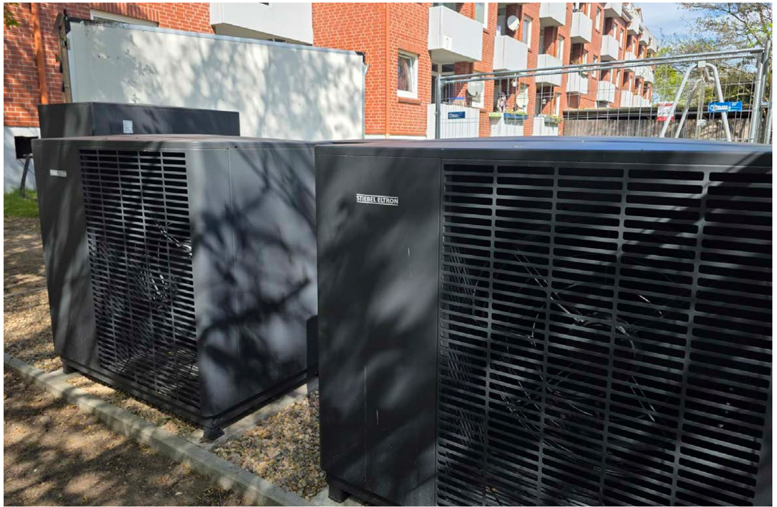
Neue Wärmepumpen mit Pufferspeichern in der Gustav-Heinemann-Straße.
