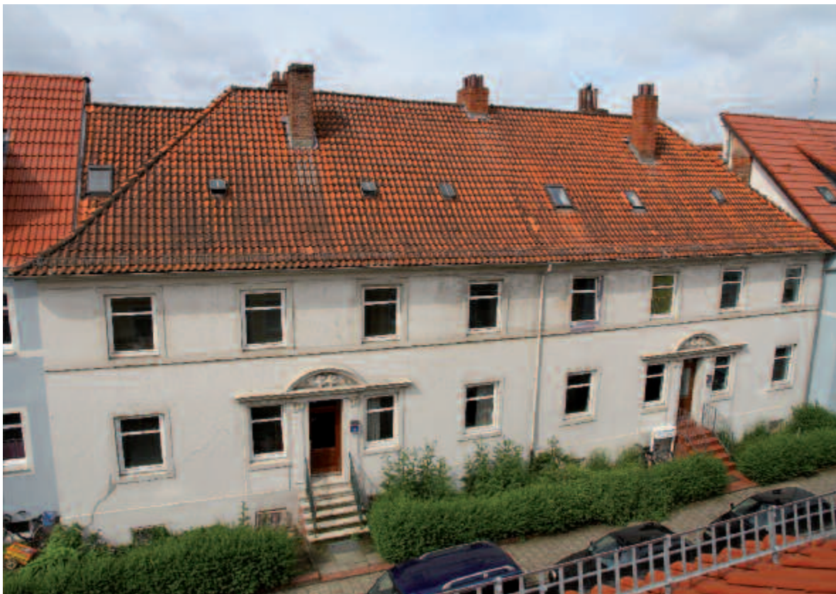
Borgfelder Str. 14–16 vor dem Abriss 2012
