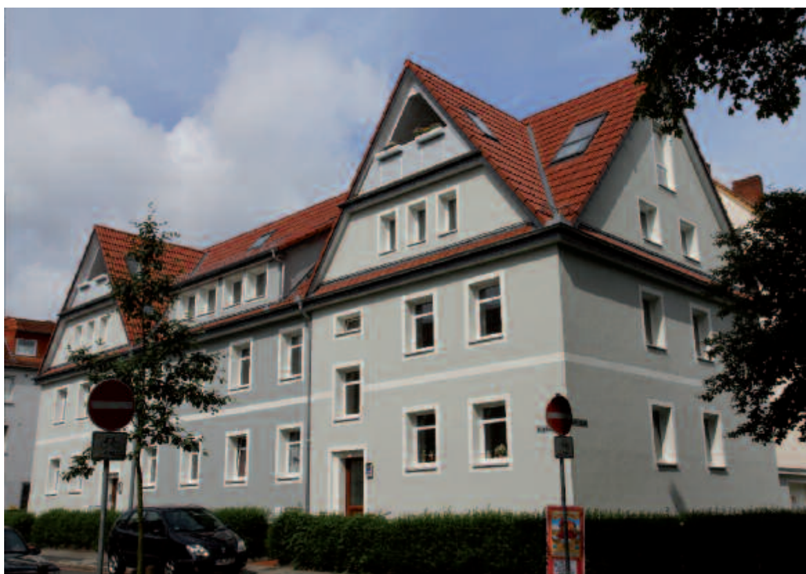
Herbststraße 122–124 nach der Modernisierung 2011
