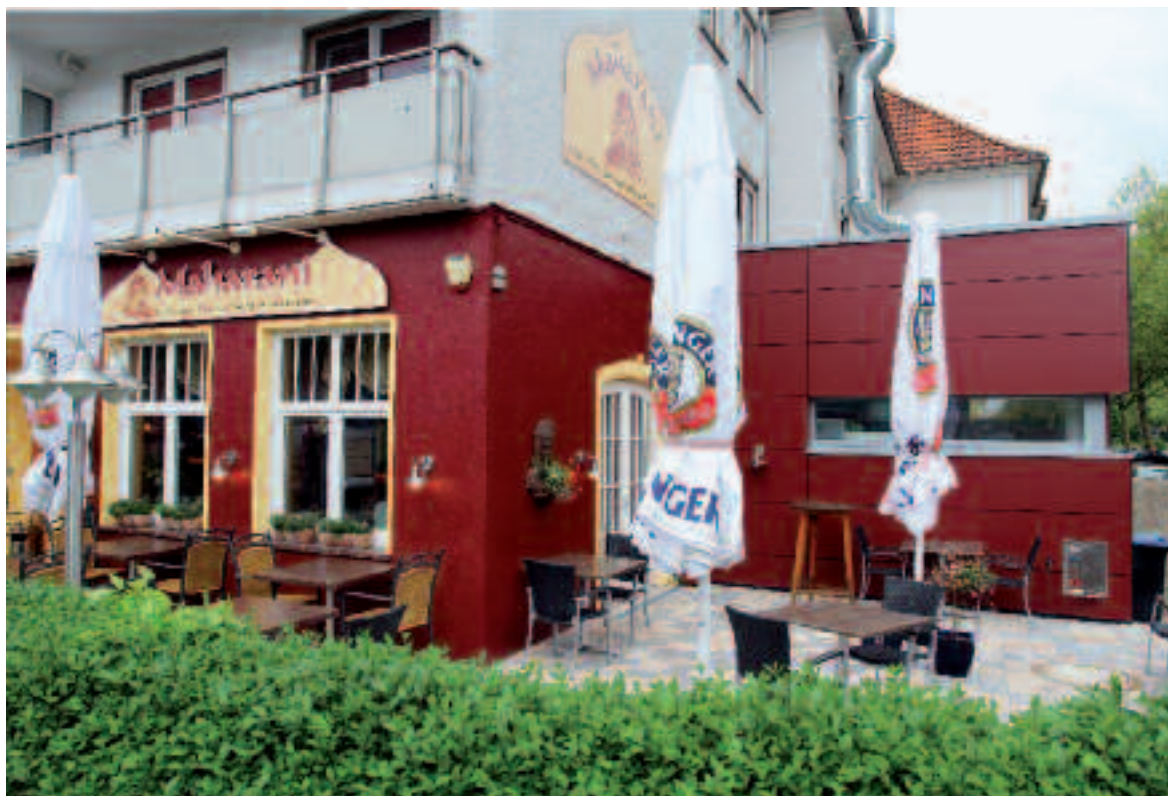
Findorffstraße/Eickedorfer Straße: Erweiterung Restaurant Maharani (ehem. Zum Minister) Foto: Kunstfotografie Schreyer
