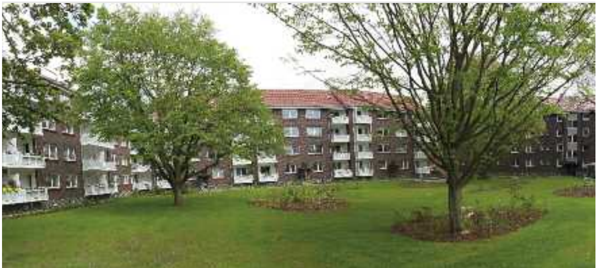
Kasseler Straße Baujahr 1957/58 nach der Modernisierung (nur rd. 60 Jahre später)
