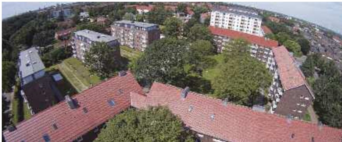
Kasseler Straße nach Modernisierung/ Dachgeschoßausbau (Vogelperspektive)
