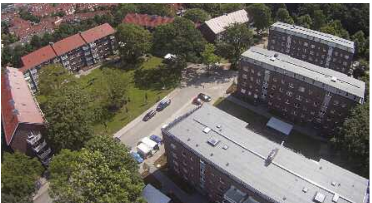
Kasseler Straße nach Modernisierung/Dachgeschoßausbau (Vogelperspektive)
