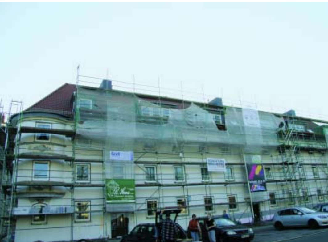
Das Objekt Utbremer Ring 124 – 146: Momentan wird die Fassade gestrichen.
