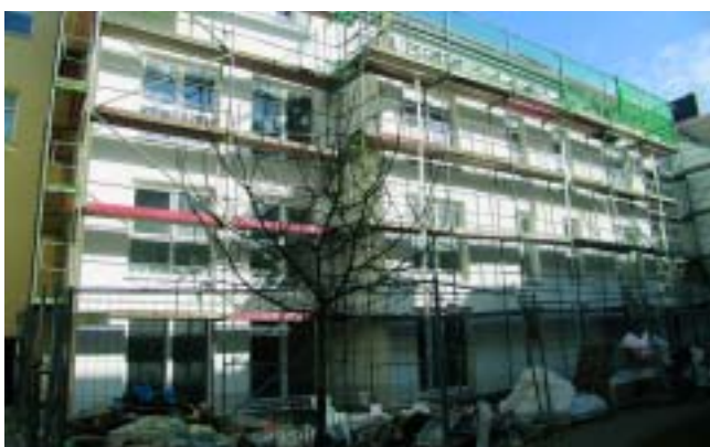
Der Hinterhof des Neubaus Borgfelder Straße 14 – 16: Anfang Mai ist das Gebäude bezugsfertig.
