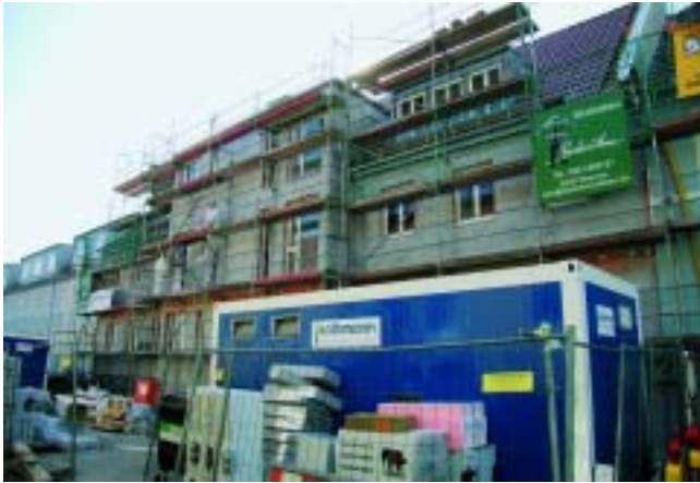
Gerade wird die Fassade wärmegeklämt. Die Baufirma Kathmann ist Generalunternehmer
