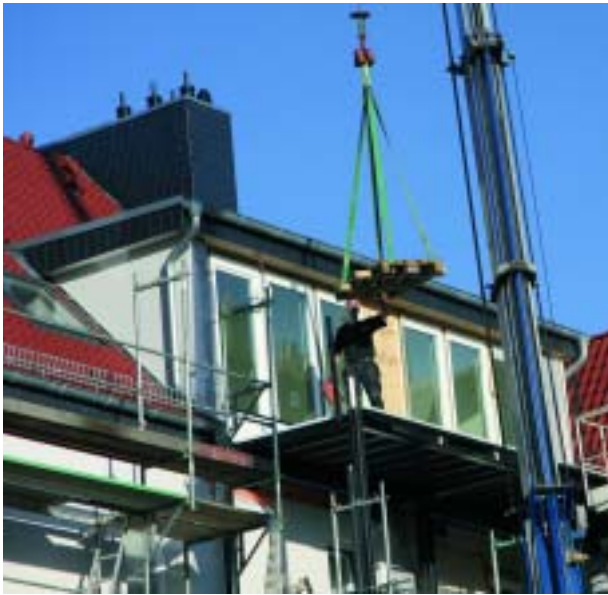
Utbremer Ring/Ecke Innsbrucker Straße: Ein Kran befördert Materialien für den Dachgeschoßausbau.
