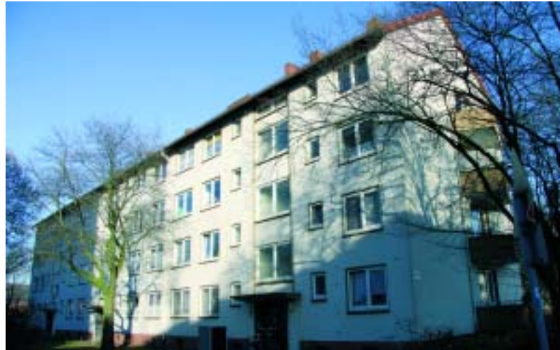
So sieht es gegenwärtig in der Kasseler Straße aus: Die Gebäude bekommen eine Klinkerfassade, die Außenanlagen werden umgestaltet.
