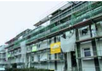
Die Borgfelder Straße: Die Straßenfront ist gedämmt, zurzeit ist der Maler da.
