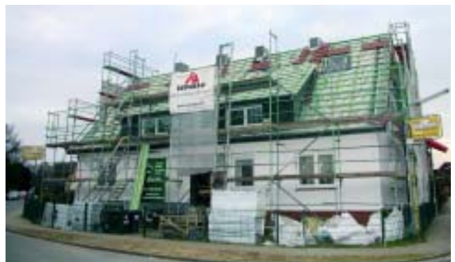
Griesborner Straße 22: Hier hat die totale Haussanierung begonnen.
