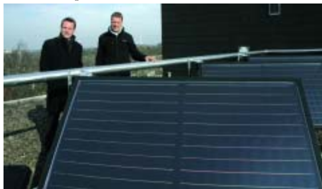
Auf dem Dach des Mehrfamilienblocks in der Hemmstraße 343 a – d: HWT-Geschäftsführer Frank Thiele (l.) und Günther Warners überprüfen die neue Solaranlage.
