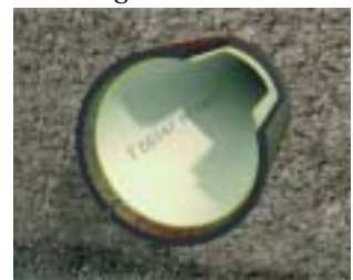
...sieht nach der Inliner-Sanierung so aus.
