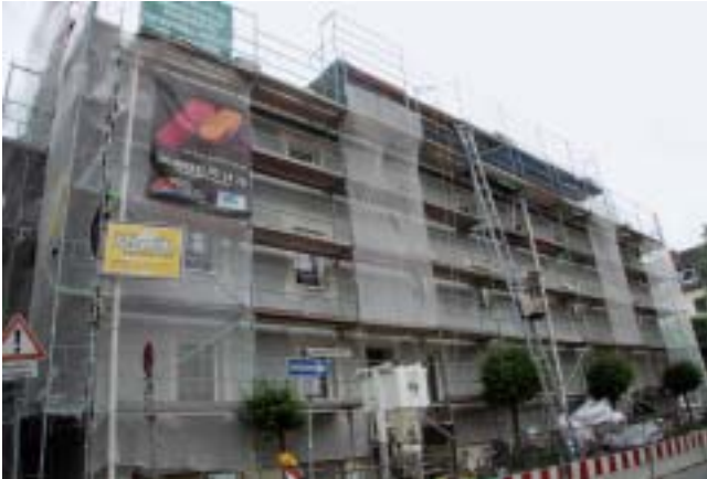
Worpsweder Straße 97 – 99: Dieses Objekt wurde vom Keller bis zum Dach saniert.
