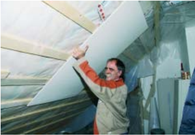
Rolf Lübke mann verarbeitet gerade den neuen Baustoff, die Platte misst 1 x 1,50 m. Die Plattenoberfläche ist werkseitig mit einem Wirkstoff aus Keratinbasis beschichtet.
