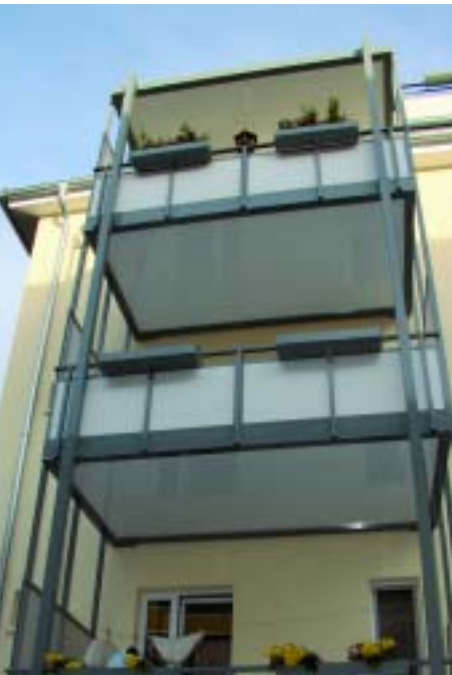
Eickedorfer Straße 31 - 36: Der tolle Blick in den Hinterhof wurde jetzt durch die Umbauarbeiten möglich. Alte Betonbalkone wurden durch doppelt so große Alu-Vorstellbalkone ersetzt.
