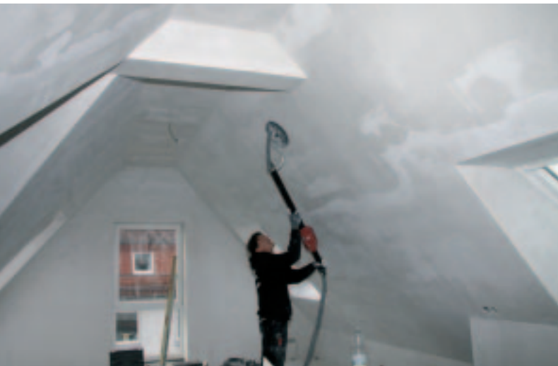
Herbststraße 122-124: Ein Trockenbauer schleift die Wände, in Kürze kommen die Maler in die neue Dachgeschosswohnung.
