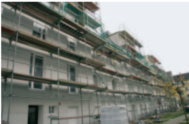
Noch verdeckt das Gerüst die neue Fassade in der Borgfelder Straße 4-12: Der Außenanstrich ist nahezu abgeschlossen, eingebaut sind bereits die neuen Fenster.
