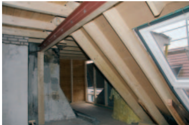
So sieht es in der Borgfelder Straße 10 aus: Die Balken sind gezogen, hier entsteht eine neue Wohnung.
