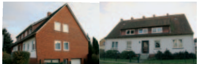
Salbacher Straße 12 (links): Hier ist für das kommende Jahr eine energetische Sanierung geplant. Die Griesborner Straße 22 (rechts) wird im kommenden Jahr ebenfalls komplett saniert.
