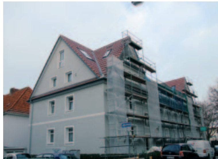
Die Außenansicht in der Herbststraße 122-124: Die Arbeiten sind fast abgeschlossen.
