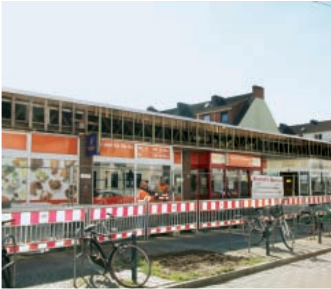
Dieses Bild in der Hemmstraße 157 gehört der Vergangenheit an: Der frühere Comet-Markt unter dem Flachdach wurde abgerissen...
