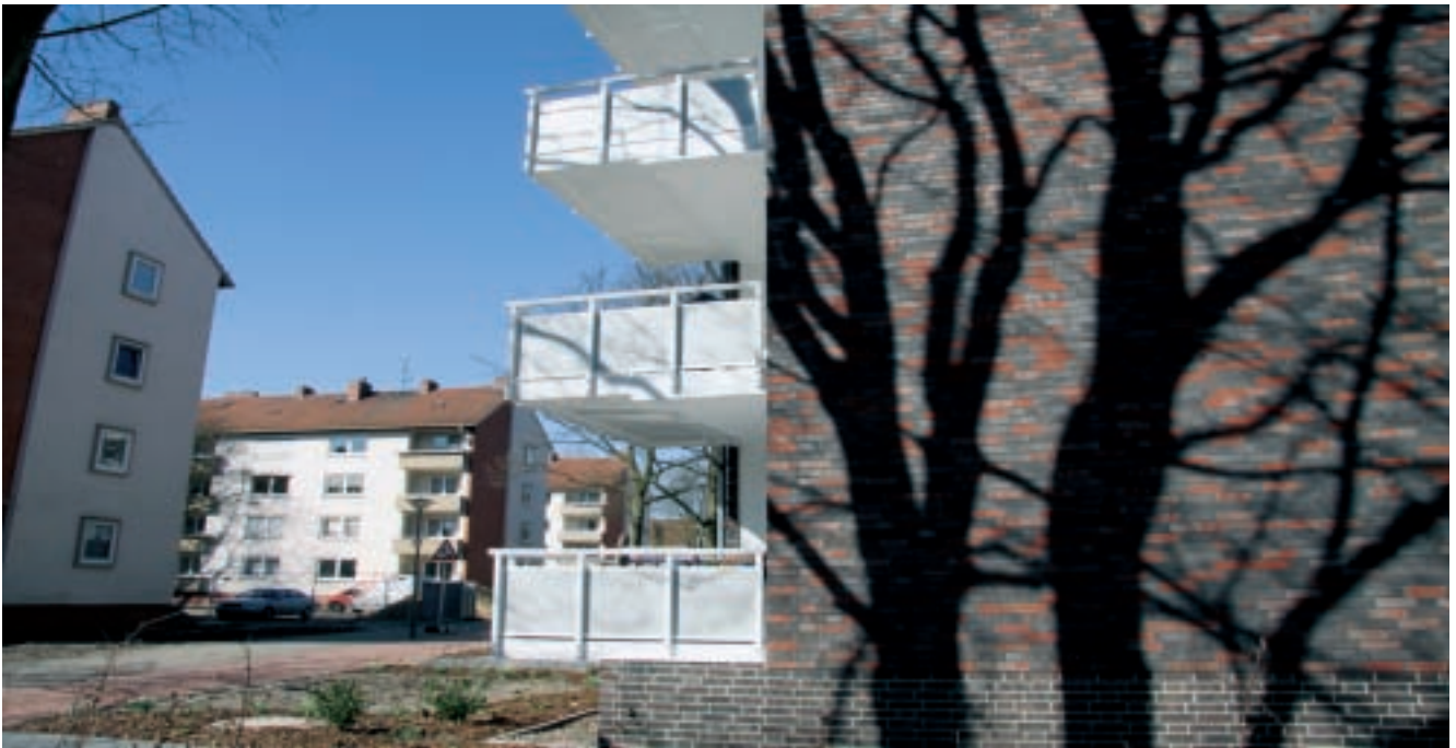
Kasseler Straße: Im Vordergrund ist ein Objekt mit der neuen klinkerfasse zu sehen, in allen drei Gebäuden hinten werden Staffelgeschosswohnungen eingebaut.
