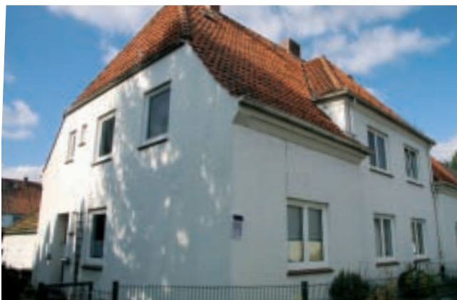
Reisweiler Straße 15/17: Wärmedämmung gehört dazu.
