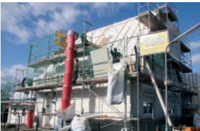
Labacher Straße 5: Die Dachdecker sind da.
