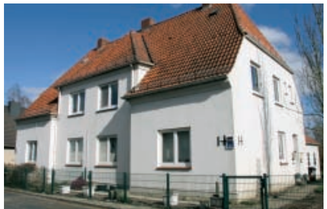
Reisweiler Straße 14/16: Neue Fenster werden eingebaut.
