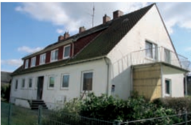
Reisweiler Straße 12: Ein neues Dach kommt.
