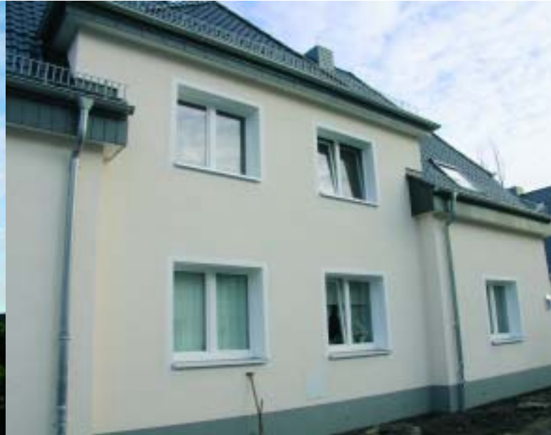
Reiszweiler Straße 14: Das Objekt ist fertig, auch hier laufen die Außenarbeiten.
