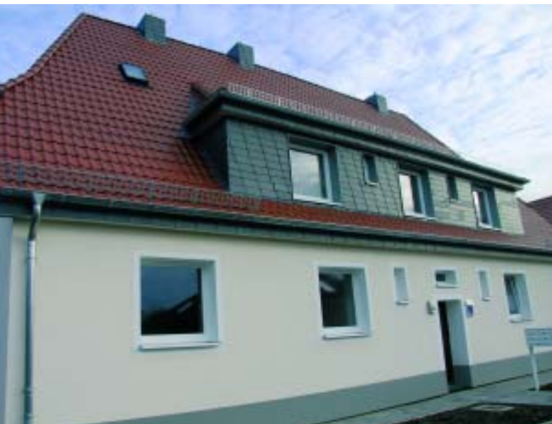
Salbacher Straße 14: Hier wird noch die Außenanlage fertiggestellt.
