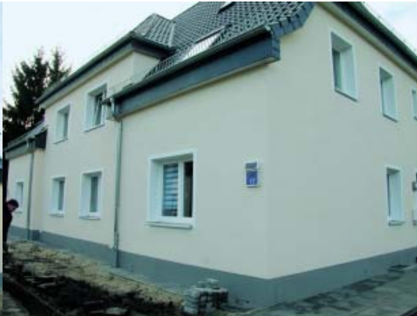
Reisweiler Straße 17: Das Gebäude ist fertig, zur Zeit laufen noch die Außenarbeiten im Vorgarten.
