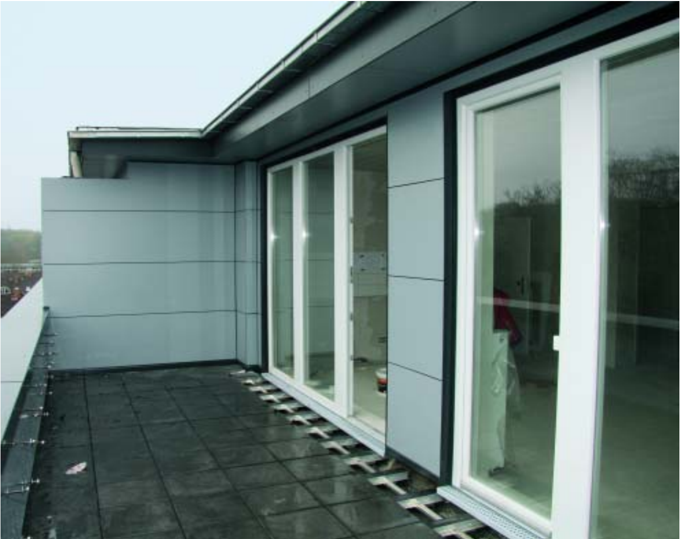
Kasseler Straße 39 – 49: Die Terrasse im Staffelgeschoss ist nahezu fertig.
