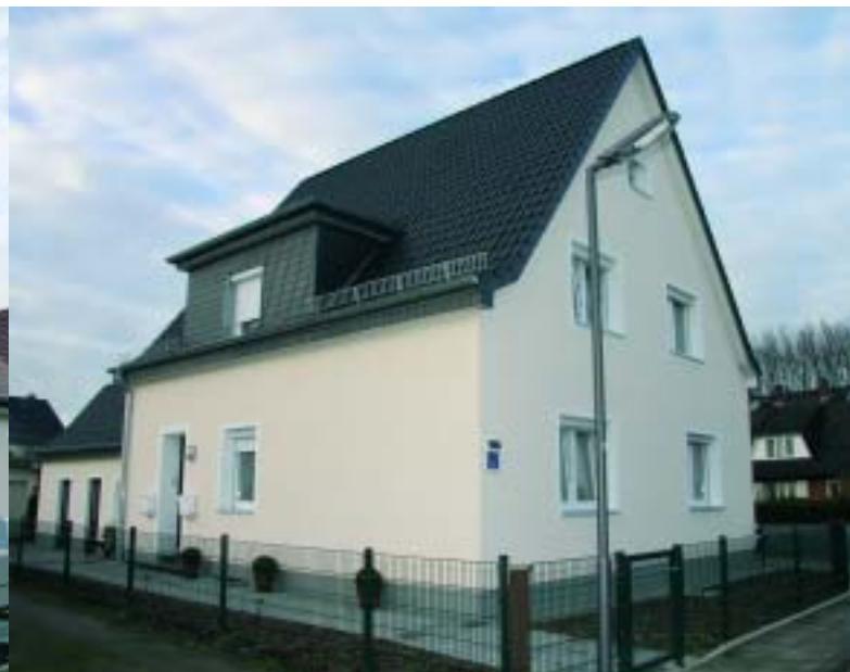
Labacher Straße 5: Auch dieses Haus kann sich nach der Fertigstellung sehen lassen.
