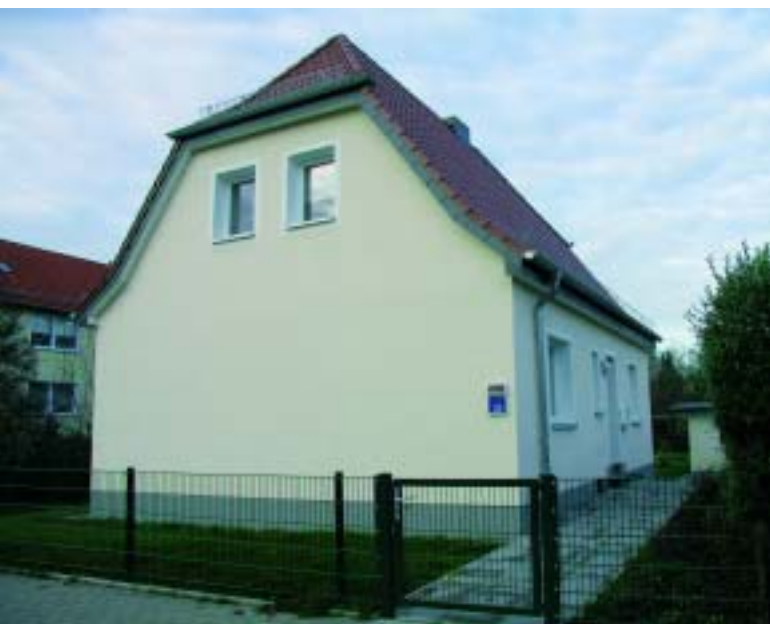
Forbacher Straße 25: Ein Paradebeispiel der Gebäudemodernisierungen – alles ist fertig.
