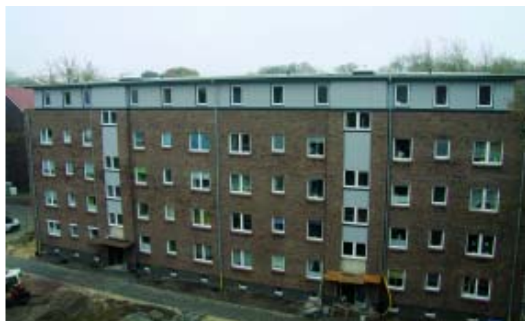
Das Dachgeschoss steht: Hier werden gerade die Innenausbauten der Staffelgeschosswohnungen fertiggestellt.
