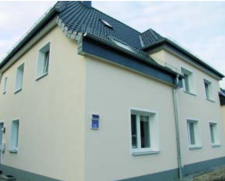
Reisweiler Straße 15: Letzte Pflasterarbeiten vor dem Haus, dann ist alles abgeschlossen.
