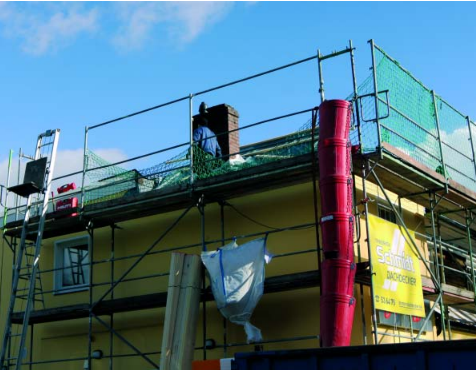
Die Baustelle Herman Post: Haupthaus und Nebengebäude wurden neu eingedeckt.
