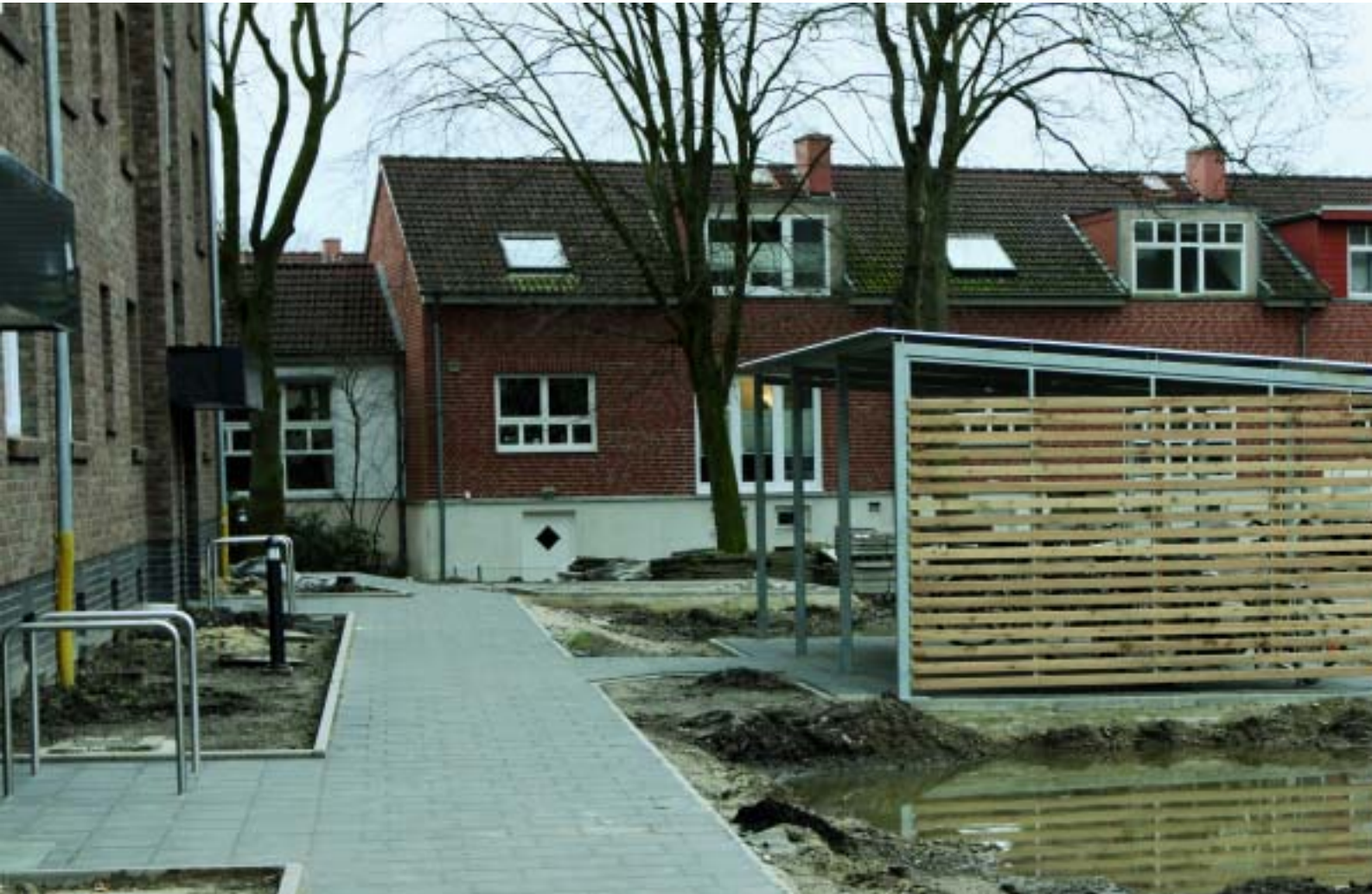
Die Zuwegung zum Wohnblock ist gepflastert, der Unterstellplatz für Fahrräder fertiggestellt.
