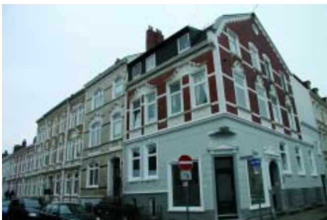
Das Objekt in der Thielenstraße/Ecke Winterstraße: Demnächst beginnt hier die energetische Gebäudemodernisierung, die Straßenseite bleibt die Schmuckfassade.
