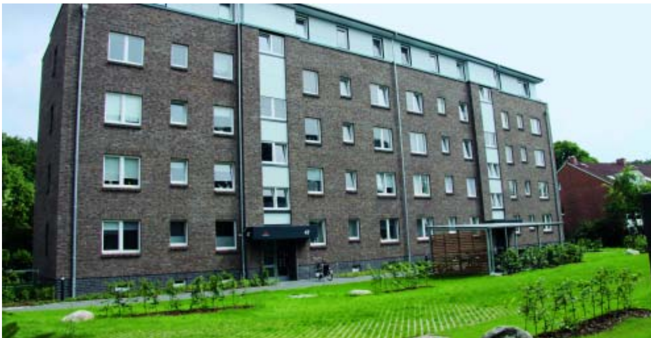
Kasseler Str. 47 – 49: Der Wohnblock mit den fünf Staffelgeschosswohnungen und seiner neuen Klinkerfassade ist ein herrlicher Blickfang...
