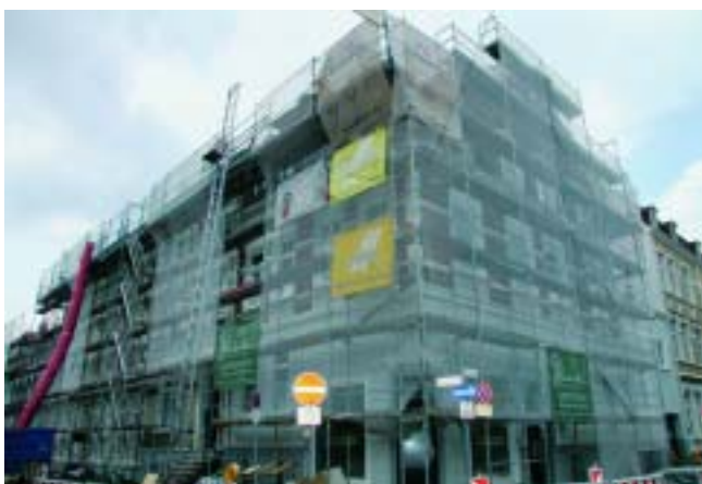
Thielenstraße 14 – 44/Winterstraße 47: Die Sanierungsarbeiten laufen bis Ende des Jahres.
