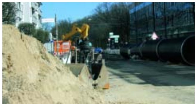
Straßensperrung der Findorffstraße/Ecke Grünbergstraße: Durch die Kanalbauarbeiten hat sich auch die Modernisierung verzögert.
