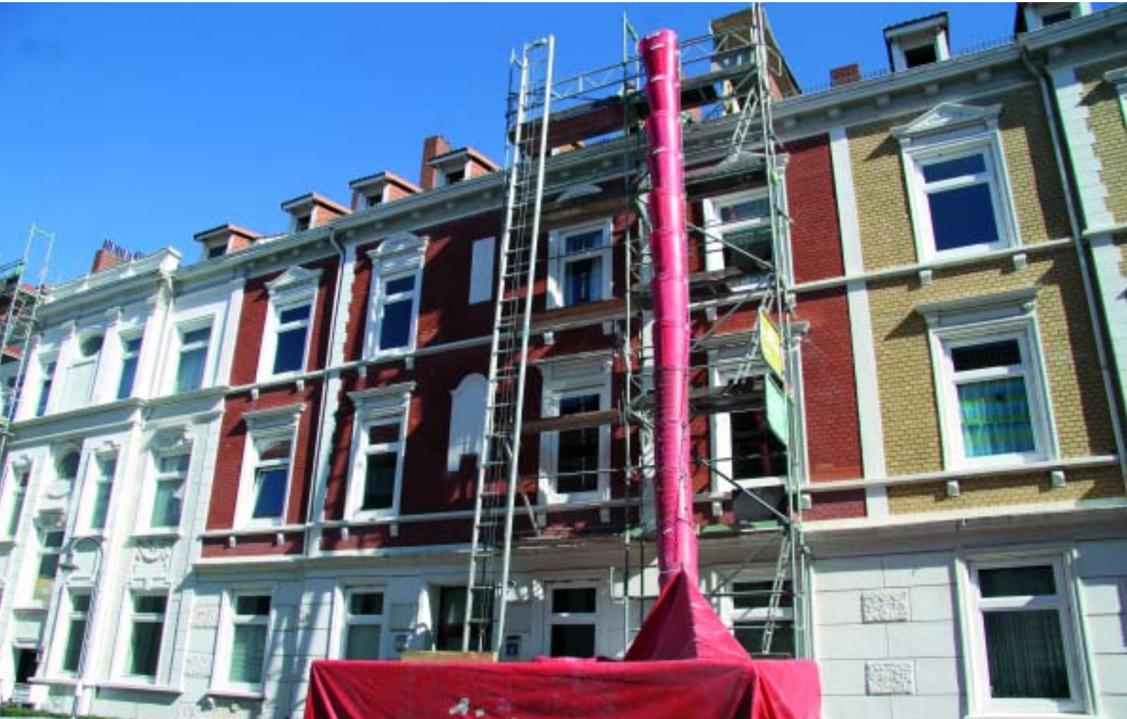
Grünbergstraße 3, 5 und 7: Gerade werden die ersten Dachkammern abgerissen.
