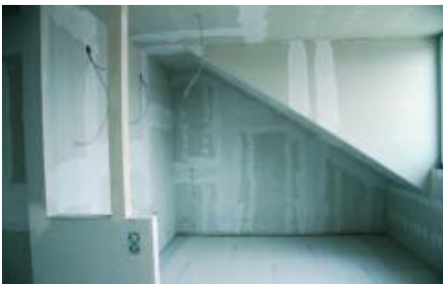
Ein Blick in den zukünftigen Küchenbereich, noch hängen die Kabel aus den Wänden.
