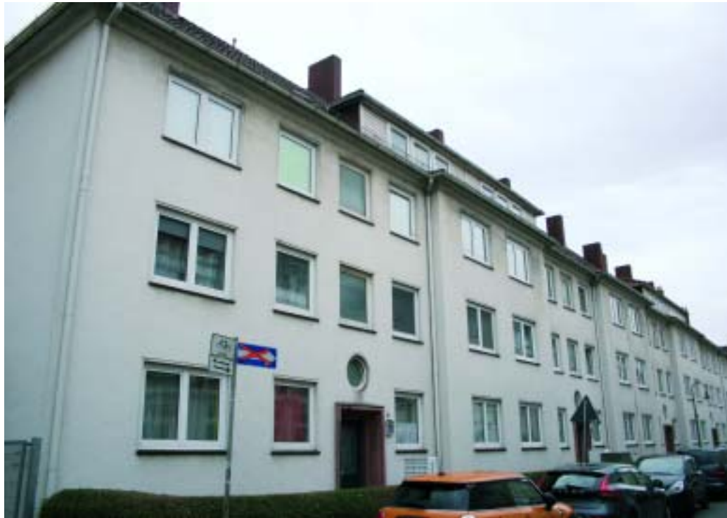
Blickfang Buddestraße: In den Eingängen 2 bis 18 werden u. a. neue Fenster eingebaut.
