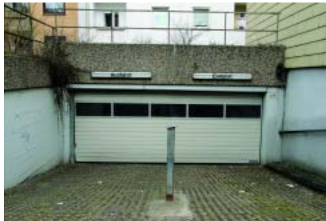
Im Sommer beginnen die Sanierungen für die Tiefgarage Thielenstraße.
