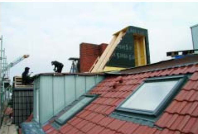
Ein Blick auf das Dach der Einheit 3 bis 9: Gerade sind die Dachdecker beim Verlegen der Dachpfannen, vorn ist der Rohbau des Aufgangs zur Dachterrasse zu sehen.
