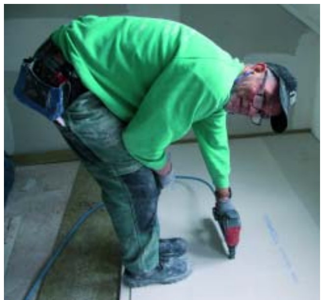
Der Trockenbauer klammert mit einem Schussapparat die Platten zusammen.
