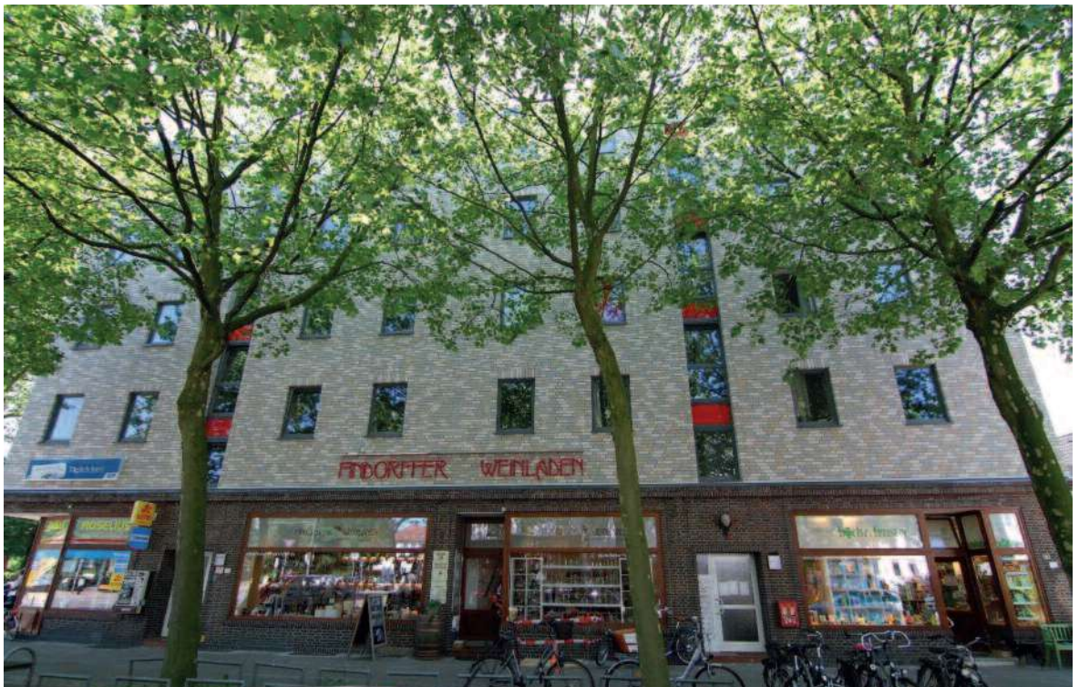
Hemmstraße 177-183 Baujahr 1930 nach der Modernisierung
