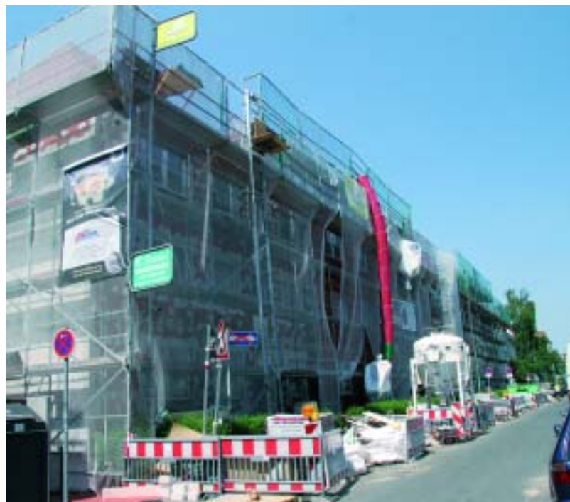
Baustelle Buddestraße: Hier haben die Sanierungsarbeiten begonnen.
