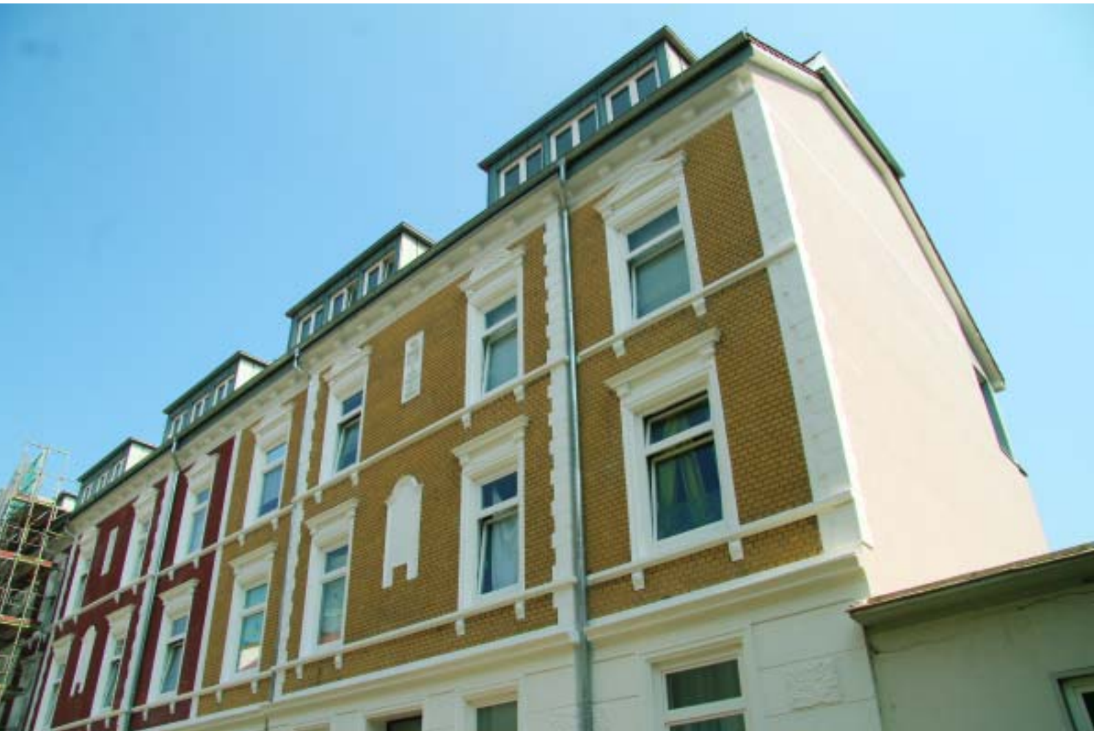
Die Außenfassade in der Einheit 3 und 5 wurde neu gestrichen – ein toller Anblick.
