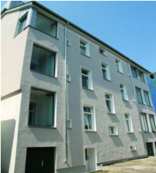
Der Innenhof in der Grünbergstraße: Neue Fenster und eine Balkonverglasung.
