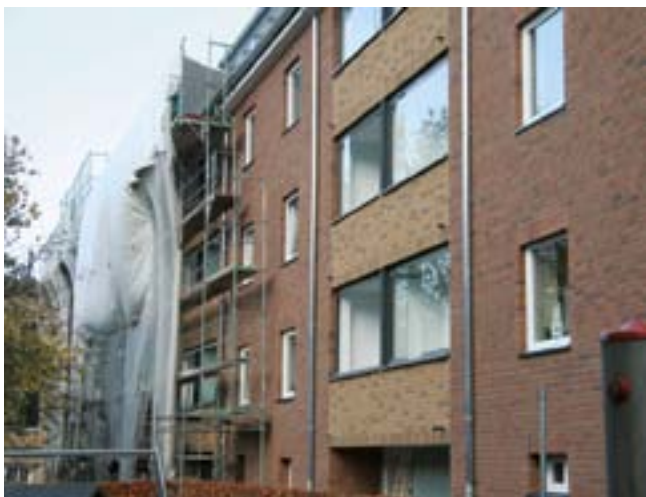
Die Balkonverglasung gehörte ebenfalls zu den Sanierungsarbeiten.
