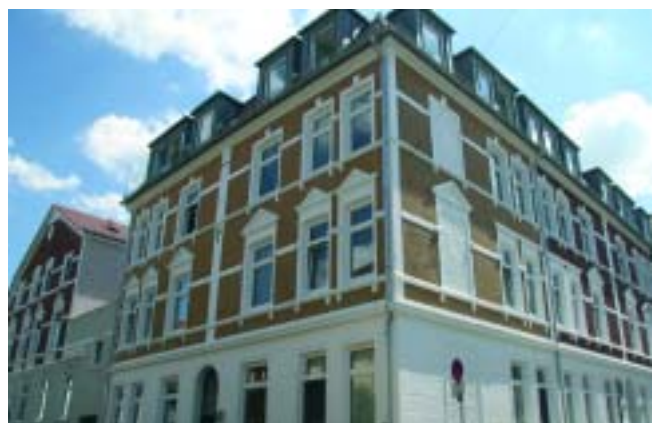
Der Gebäudekomplex Grünbergstraße 3-25/Ecke Winterstraße in Vollendung.
