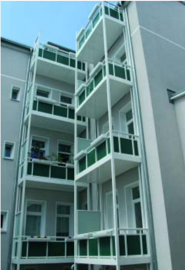
So präsentiert sich die Fassade im Innenhof der Winterstraße 45. Eine Loggia mit einem vorgelagerten Balkon entstand in der oberen Wohnung, auch die Vorstellbalkone sind neu.
