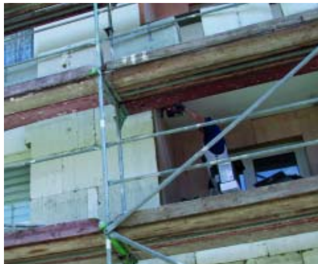
Ein Handwerker verkleidet gerade die Fassade.
