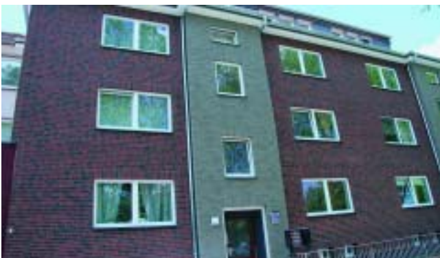
So präsentiert sich die Eickedorfer Straße nach der Fertigstellung.
