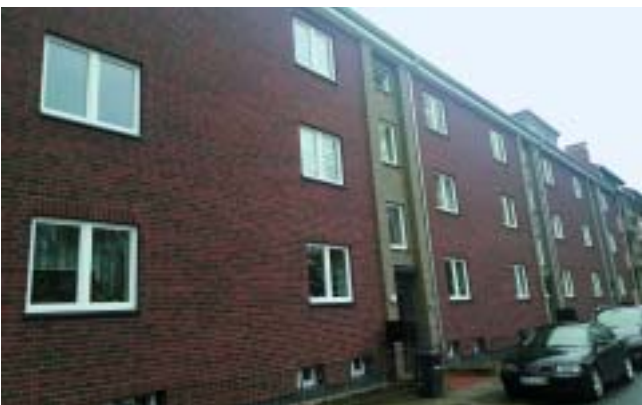
Die Eickedorfer Straße ist fertiggestellt: Nach der energetischen Sanierung präsentiert sich der Straßenzug als einheitliches Bild.
