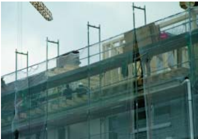
Die Zimmerleute setzen die Balken für die Loggia.
