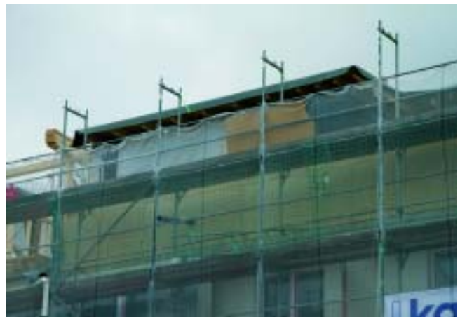
Diese Wohnung im Staffelgeschoss ist so gut wie fertig.
