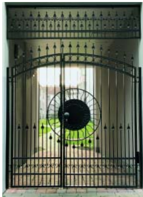
So sieht das schmiedeeiserne Tor in der Winterstraße 45 aus. Das Material ist „gehämmerter Stahl“ und wurde pulverbeschichtet.
