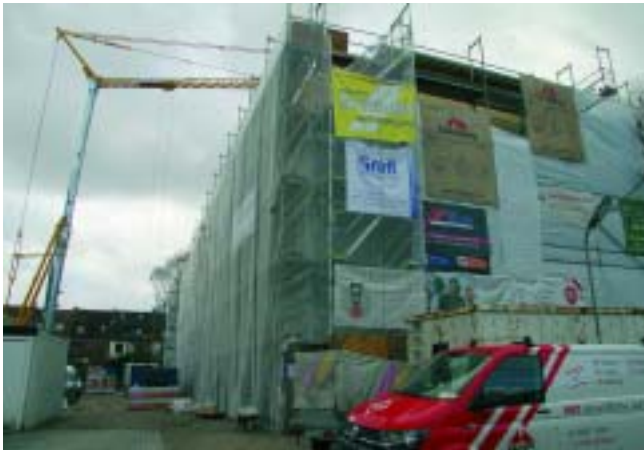
Leipziger Straße 44-56: An diesem Block wird für den Ausbau der Staffelgeschosse gerade ein Kran eingesetzt.
