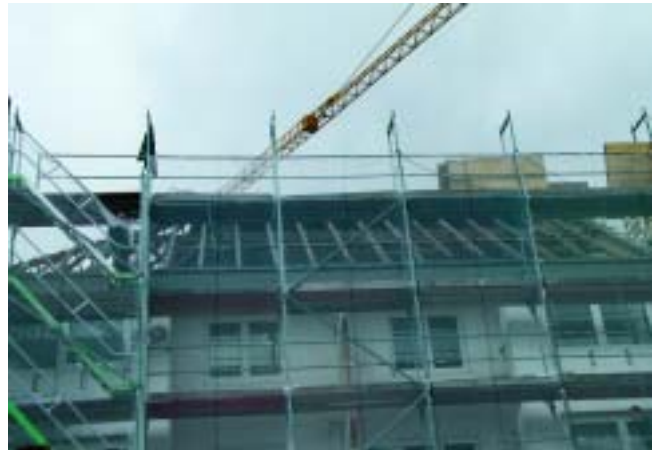
Der alte Dachstuhl des Satteldaches wird abgerissen.
