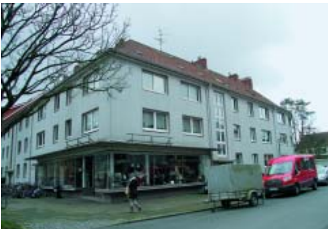
Dieser Teil der Dresdener Straße 1 – 3 wird 2021 saniert.
