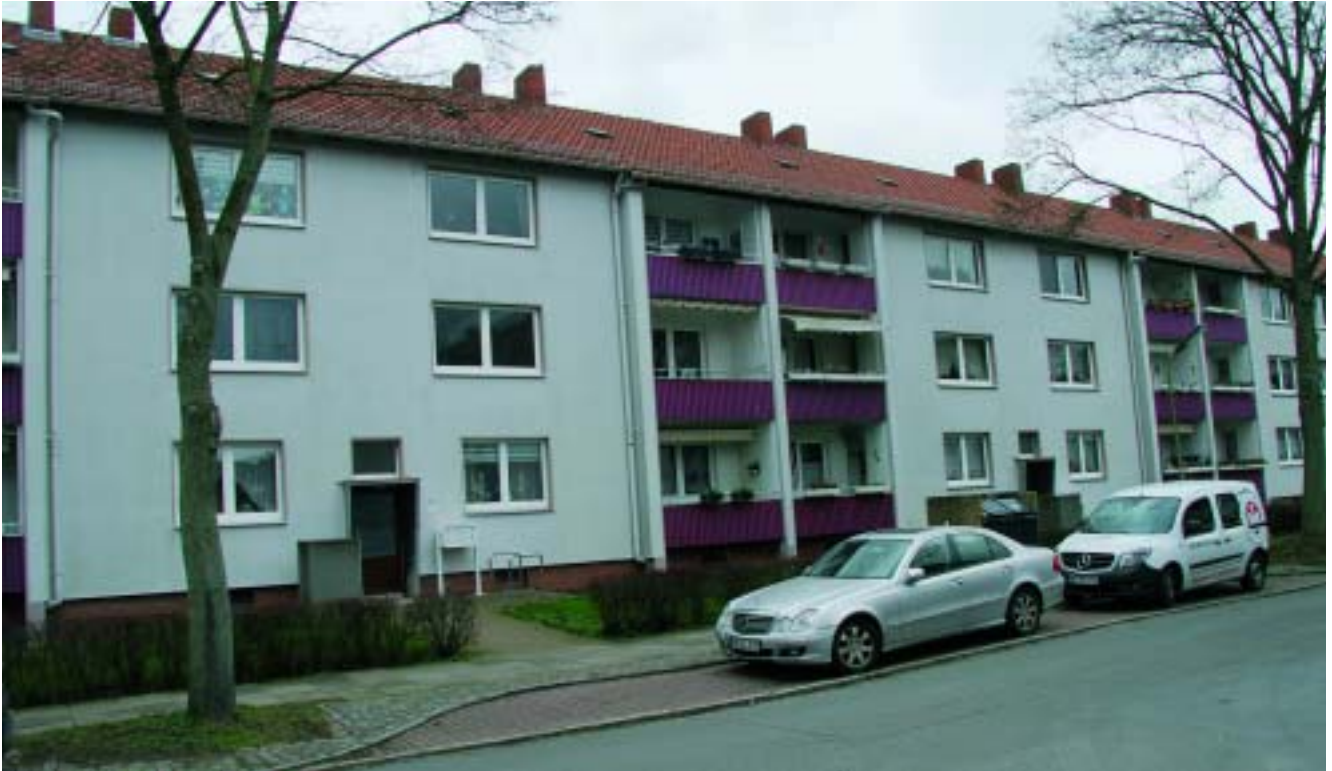
Noch unberührt ist der Block in der Leipziger Straße 21 – 25.
