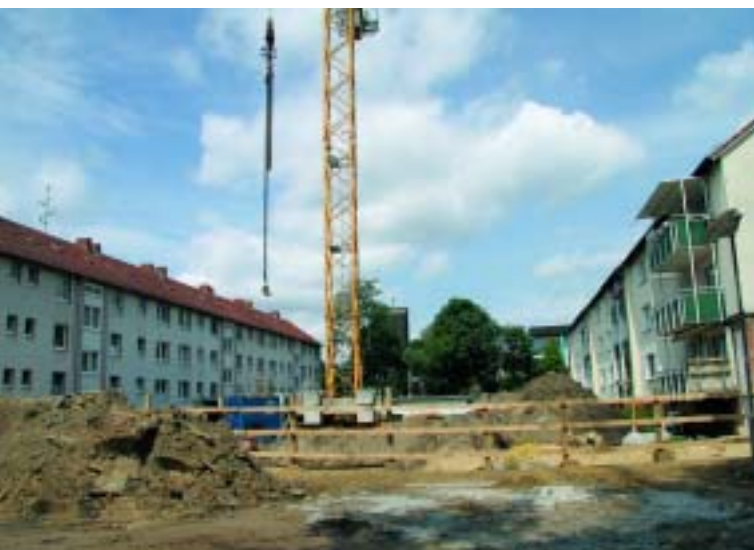
Zwischen diesen beiden Häusern ist in der Dresdener Straße 8 das Baugrundstück hergerichtet worden.
