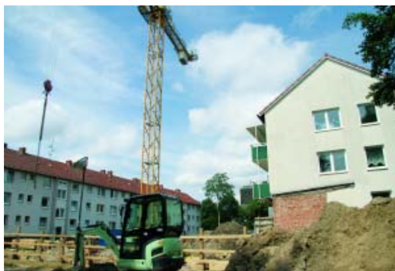
Die momentan größte Baustelle unserer Genossenschaft in der Dresdener Straße. Hinten ist das Haus der Leipziger Straße 21 – 25 zu sehen, rechts das Wohngebäude der Halberstädter Straße 45 – 49.
