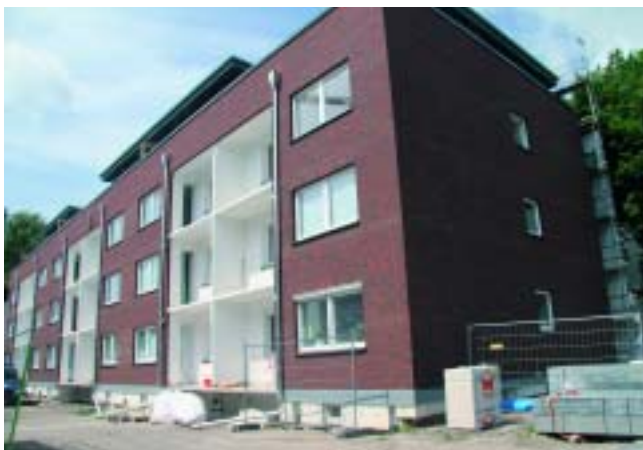
Noch ist das mittlere Haus verhüllt: Hier wird gerade die Außenfassade isoliert.
