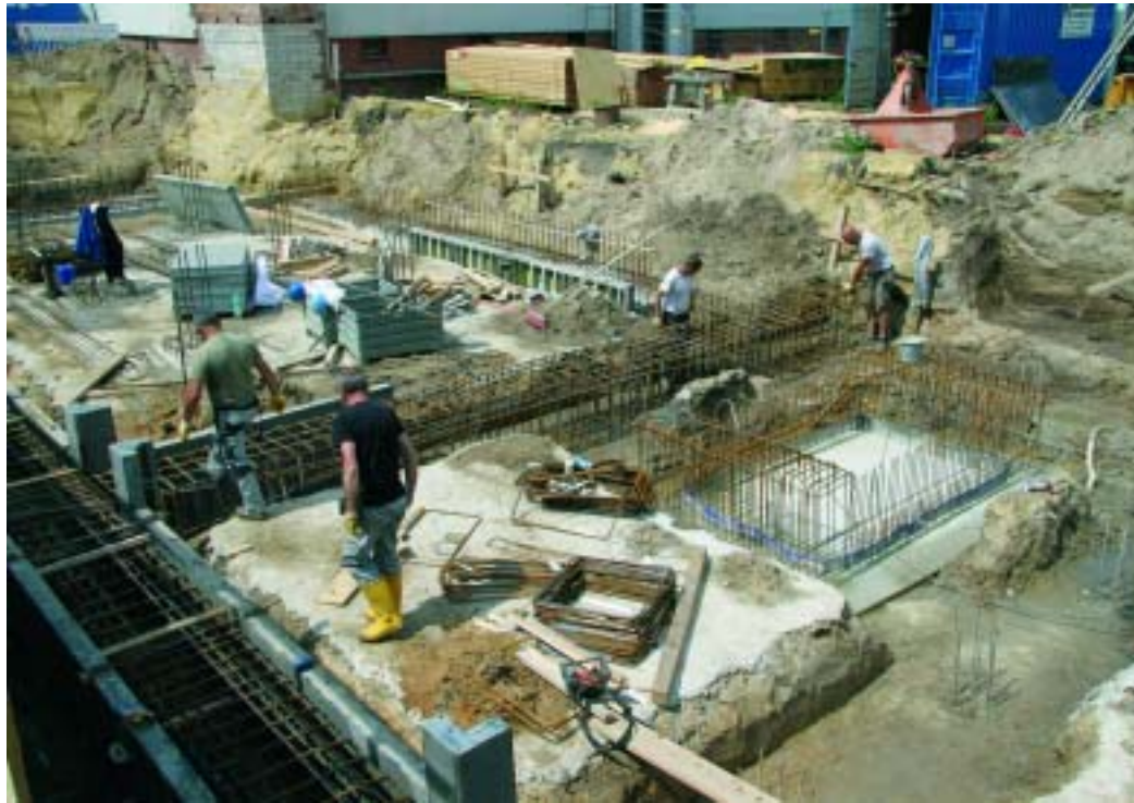
Die Vorbereitung für das Gießen der Solplatte laufen.
