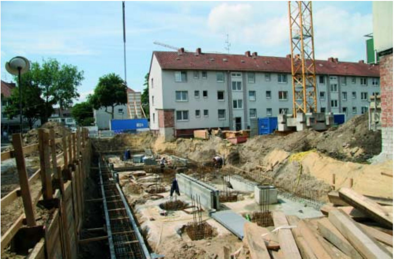
Die Baustelle in der Dresdener Straße: Nach dem Abriss des Geschäfts-Pavillons läuft der Bau des neuen Wohngebäudes.
