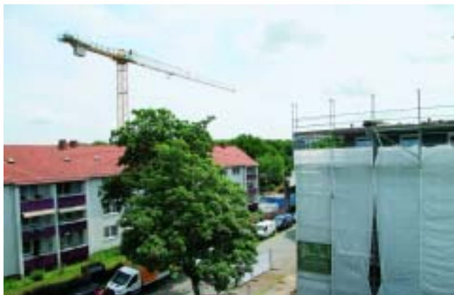
Ein Blick aus der Loggia von Haus 52 über das Haus 48 über zur Großbaustelle Dresdener Straße.
