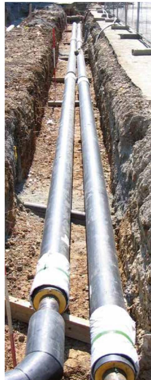
Die Fernwärmeleitung wird im oberen Bild unterirdisch verlegt und in der Abbildung rechts oberirdisch.
